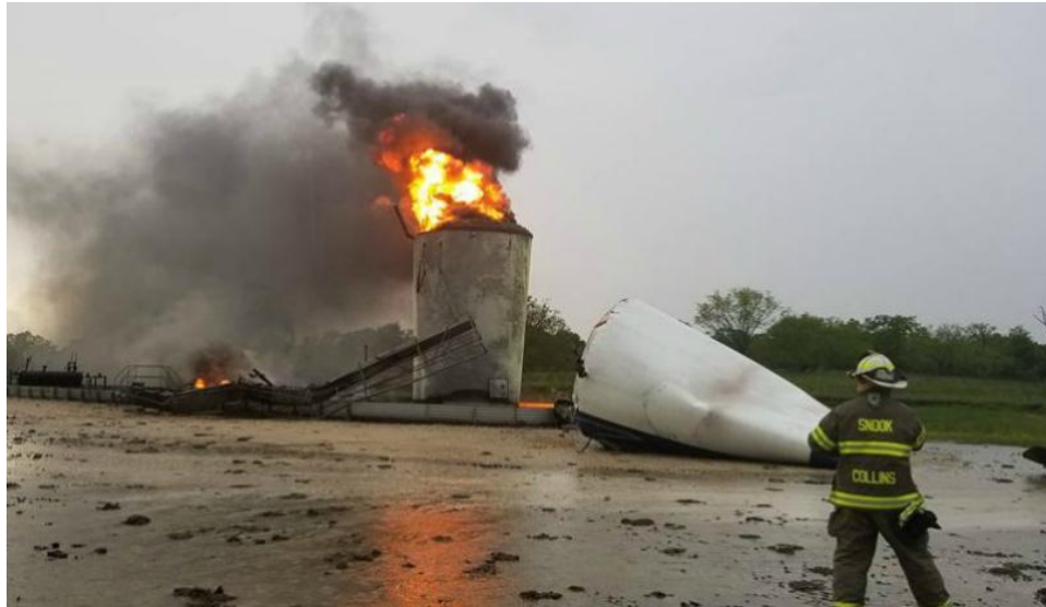
Hình 3-63: Sét đánh gây cháy các bể dầu ở Quận Burleson năm 2018. 353
