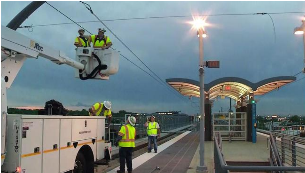
Hình 3-62: Đội bảo trì đang sửa chữa tuyến đường ray Carrollton DART bị hư hại do sét đánh. 345
