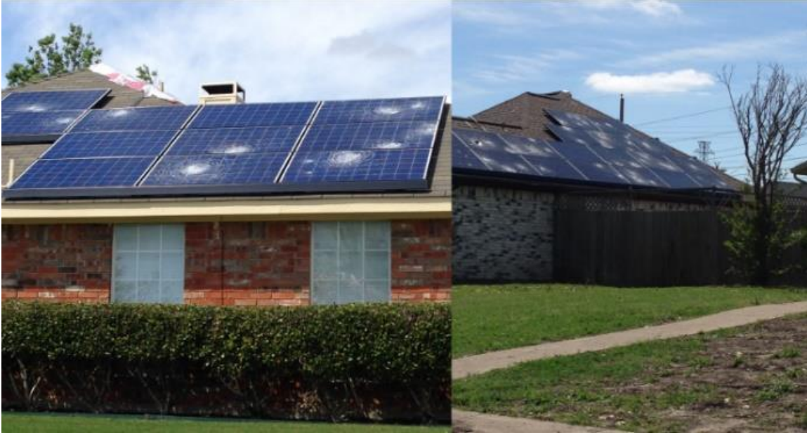
Hình 3-46: Mưa đá gây thiệt hại cho các tấm pin mặt trời dân cư. 216
