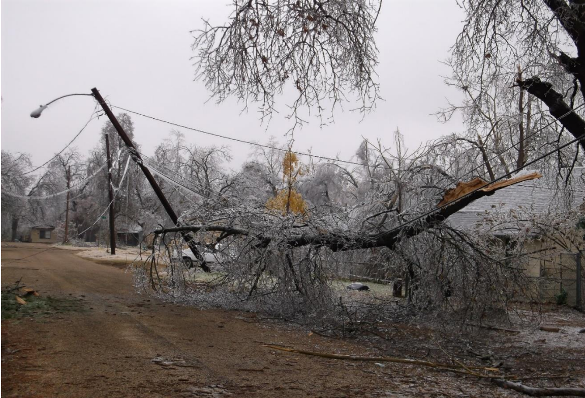
Hình 3-60: Đường dân điện bị rơi trong trận bão băng 2013 ở Paris, Texas. 334
