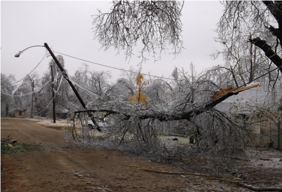
Figura 2-58: Línea de energía eléctrica derribada durante la tormenta de hielo de 2013 en Paris, Texas. 330
