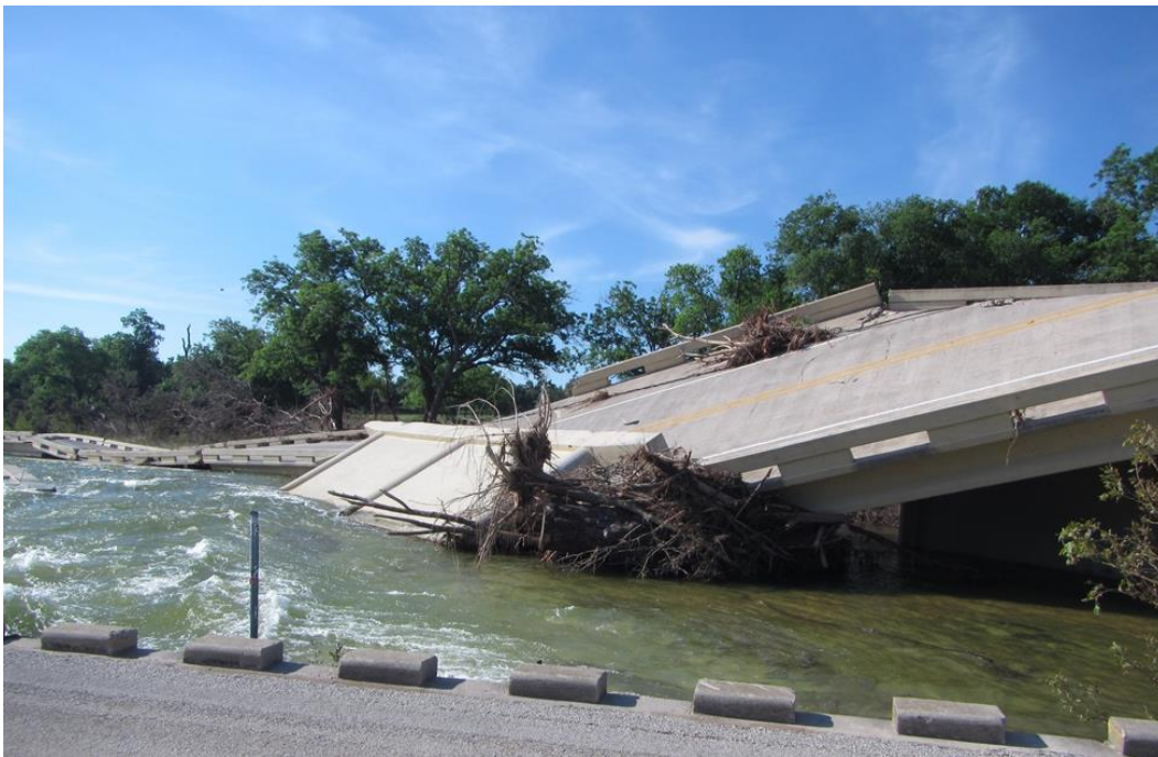
Figura 2-1: Puente Fischer Store Road sobre el río Blanco. 4
