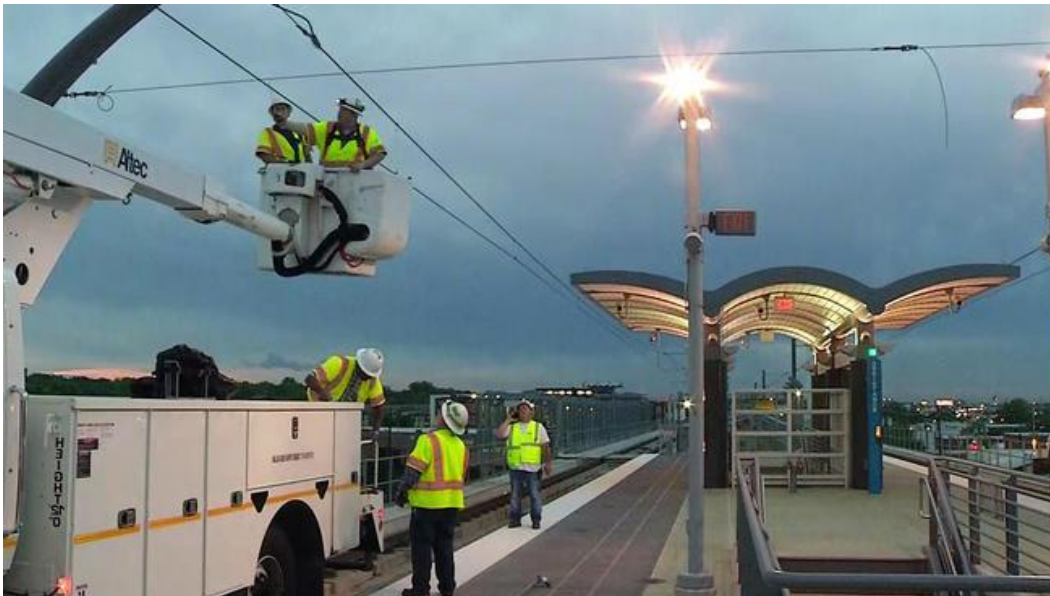
Figura 2-60: Equipos trabajan para reparar la línea ferroviaria de DART de Carrollton dañada por relámpagos. 341
