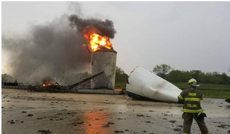
Figura 2-61: Tanques de petróleo encendidos por relámpagos en el condado de Burleson en 2018. 349
