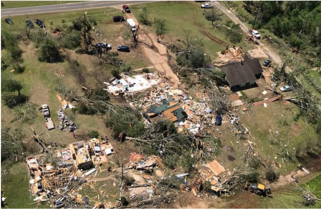
Figura 2-46: Daño a zona residencial por tornado en el condado Cherokee, tornados de abril de 2019. 230
