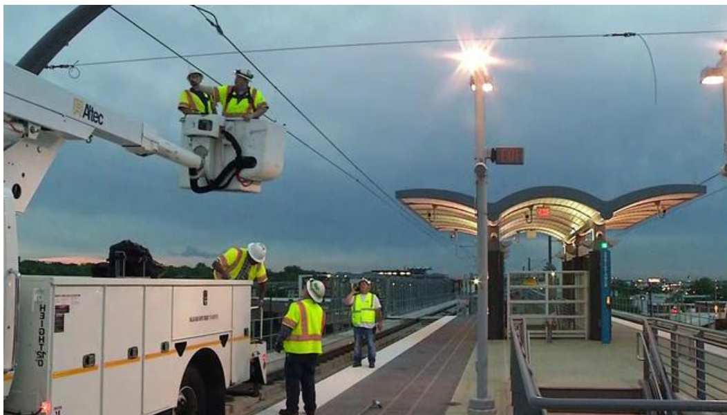
Figura 3-62: Equipos trabajan para reparar la línea ferroviaria de DART de Carrollton dañada por relámpagos. 345
