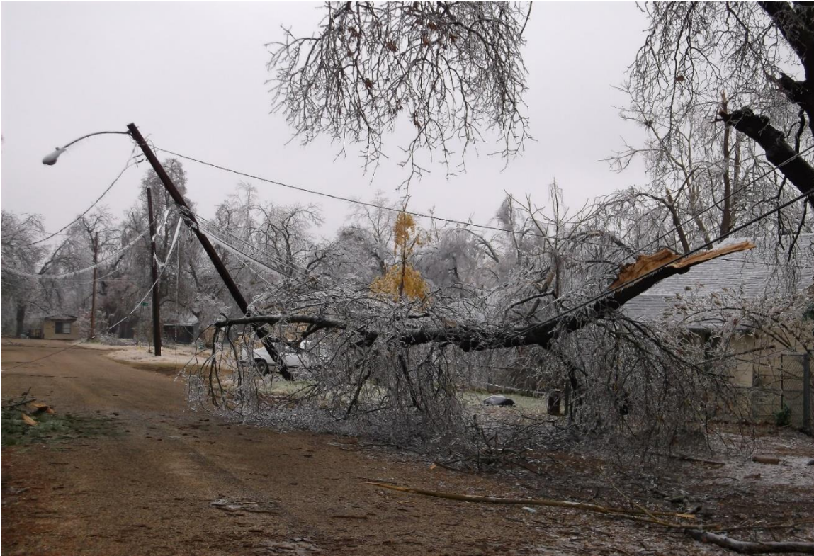
Figura 3-60: Línea de energía eléctrica derribada durante la tormenta de hielo de 2013 en Paris, Texas. 334
