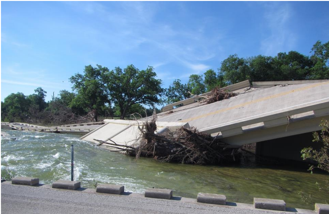
Figura 3-1: Puente Fischer Store Road sobre el río Blanco. 4
