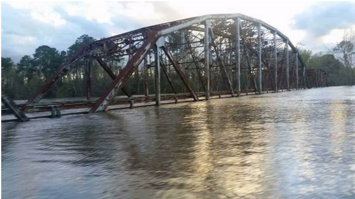
Puente Burr's Ferry SH63 sobre el Río Sabine – Foto por el Departamento de transporte de Texas
